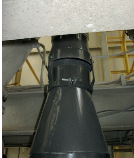
Afb. 3 Detail van een trekonderbreker
